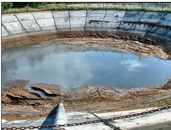
Bild 1. Behälter für Schweinegülle nach der Entleerung ohne Produktanwendung Ablagerungen infolge unvollständiger Gülleumsetzung
