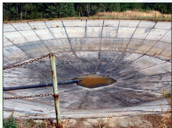
Bild 1. Behälter für Schweinegülle nach der Entleerung ohne Produktanwendung Ablagerungen infolge unvollständiger Gülleumsetzung
